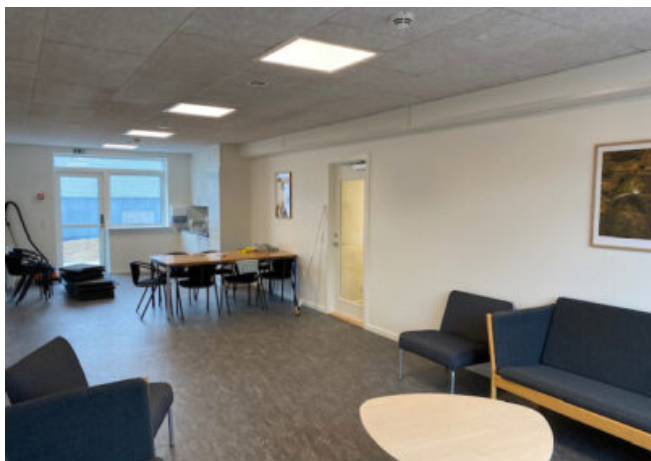
lydabsorbering, gipsvægge med væv, lofter med troldekt
